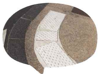
Passage piétons podotactile : Avenue de la libération
