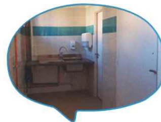
Toilettes : Foyer Rural & Salle Lucien Blanchard
