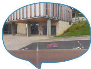
Parkings avec place handicapé
