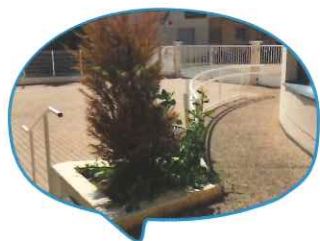
Rampe d'accès : Mairie (Salle Lucien Blanchad) Cantine Ecole Marcel Pagnol, Ecole René Cassin
