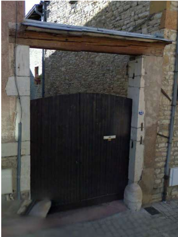
Porche en centre ancien, le portail a conservé les proportions originelles
