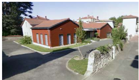
Mur de pierre maintenu dans le cadre d'un projet d'aménagement, Anse
