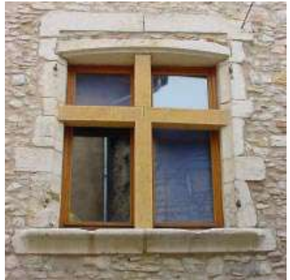
Un exemple de verre moderne sur un bâtiment ancien, ou les reflets soit du ciel soit des immeubles situés en face, créent un effet désagréable, qui déstructure l'architecture.
