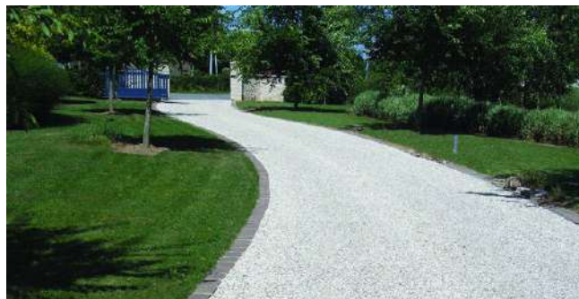
Entrée de garage sol perméable (gravier renforcé)
