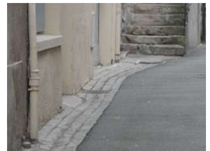
pavés en pieds de façade
