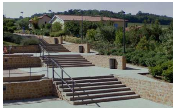
Aménagement sur Anse
