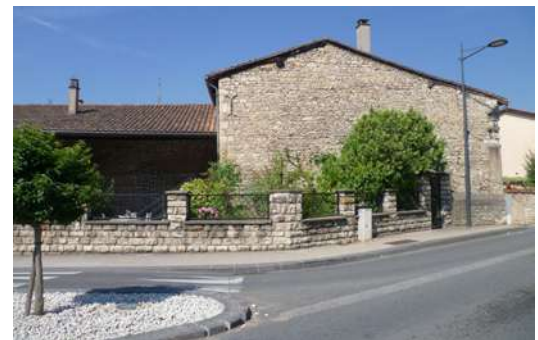
clôture d'origine du quartier de la Libération à maintenir, Anse
