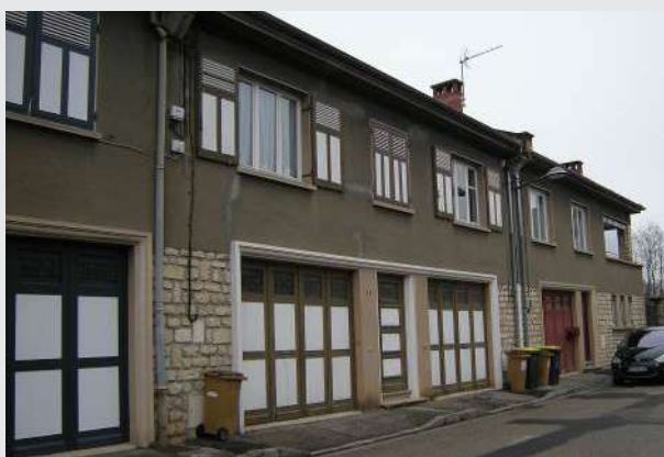
Façade originelle (parement pierre, enduit...)
