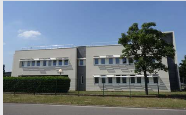
Immeuble de bureau après isolation
