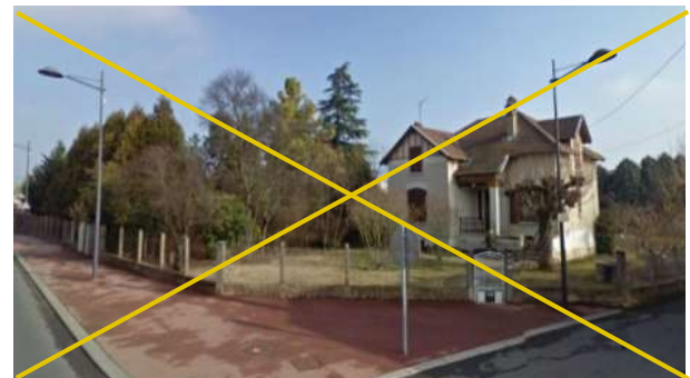
Clôture : simple grillage et poteaux béton, traitement déconseillé notamment sur l'espace public
